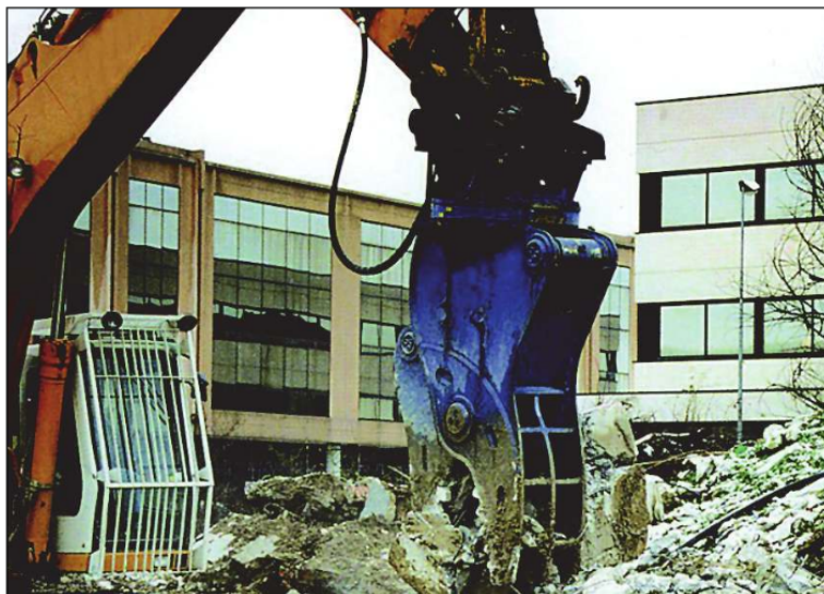
FOTO DI UN ESCAVATORE CON PINZA DEMOLITRICE
